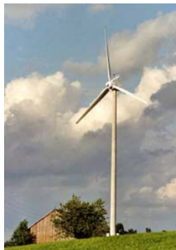
Aventa 6 kW in Oberhelfenschwil SG
