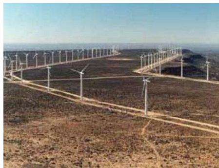
King Mountain Wind Park, Texas USA Gesamtleistung 278.2 MW
