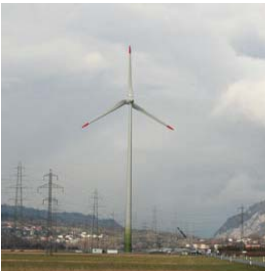
Figur 18: Das „Paradepferd“ der schweizerischen Windenergienutzung steht in Collonges im Kanton Wallis. Diese 2 MW-Anlage produzierte im Jahr 2006 total 4.4 GWh Strom, womit ein Kapazitätsfaktor von 25% resultiert - ein absolutes Rekordergebnis und vergleichbar mit Standorten in Küstenländern! (siehe auch Bild auf dem Deckblatt)
