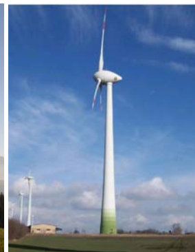
Enercon E-112, 5 MW
